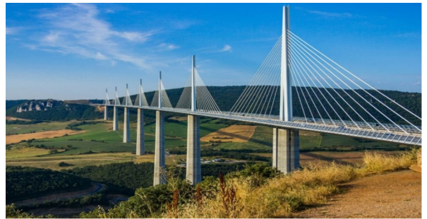
图7 某多塔斜拉桥
