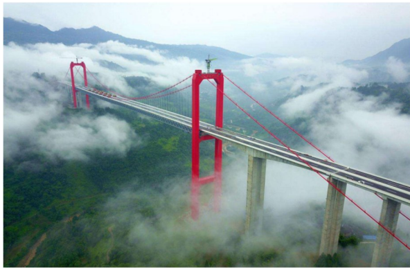
图5 某双塔悬索桥
